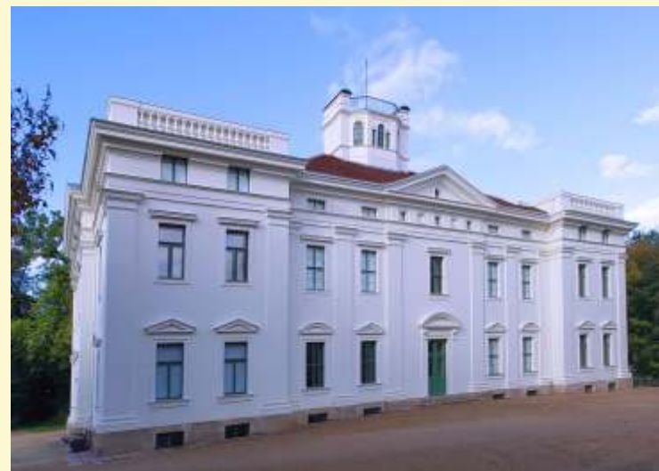
Anhaltische Gemäldegalerie nach der Sanierung 2021
